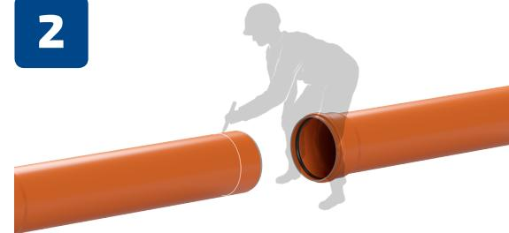
На гладком конце трубы необходимо сделать монтажную метку с тем расчетом, чтобы труба не доходила до упора в растворе на 10 мм.
