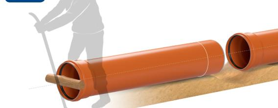
Гладкий конец ПВХ трубы необходимо вставить в раствор на глубину монтажной метки. Соединение труб осуществляется с помощью специального устройства для сборки ПВХ труб с зажимными хомутами, либо вручную, при этом в качестве рычага можно пользоваться ломом (между поверхностью лома и торцом трубы необходима деревянная прокладка).
