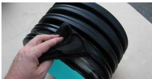
Рисунок 19 – Очистка поверхности конца трубы
