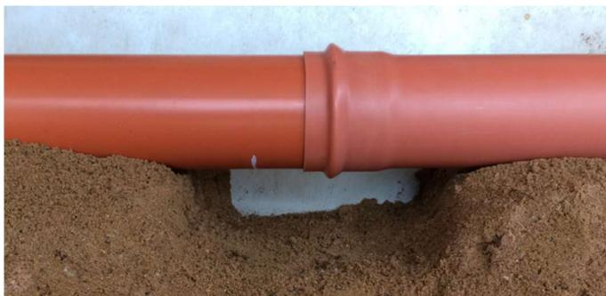
Рисунок 13 — Обустройство приямка под местом соединения труб на дне траншеи
