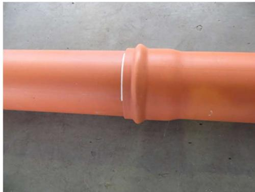
Рисунок 21 — Соединение трубы в раструб до монтажной метки
