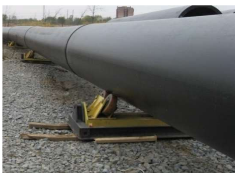
Рисунок 6 – Использование роликовых опор при прокладке трубопроводов
