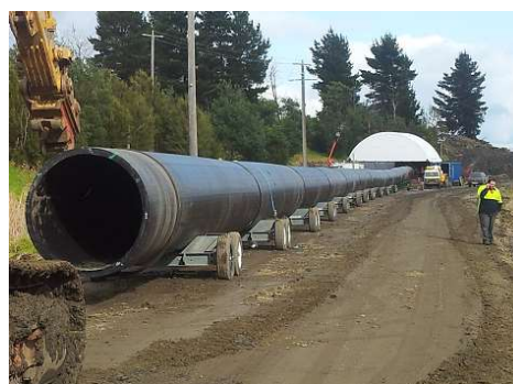
Рисунок 6 – Использование роликовых опор при прокладке трубопроводов
